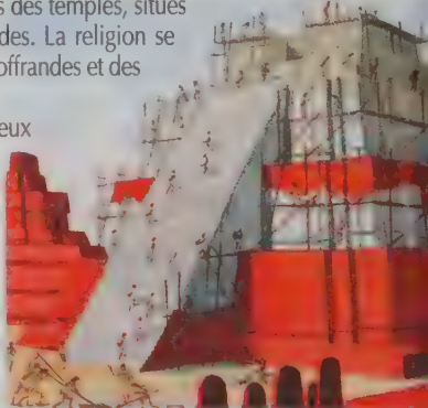
Construction d'une pyramide
