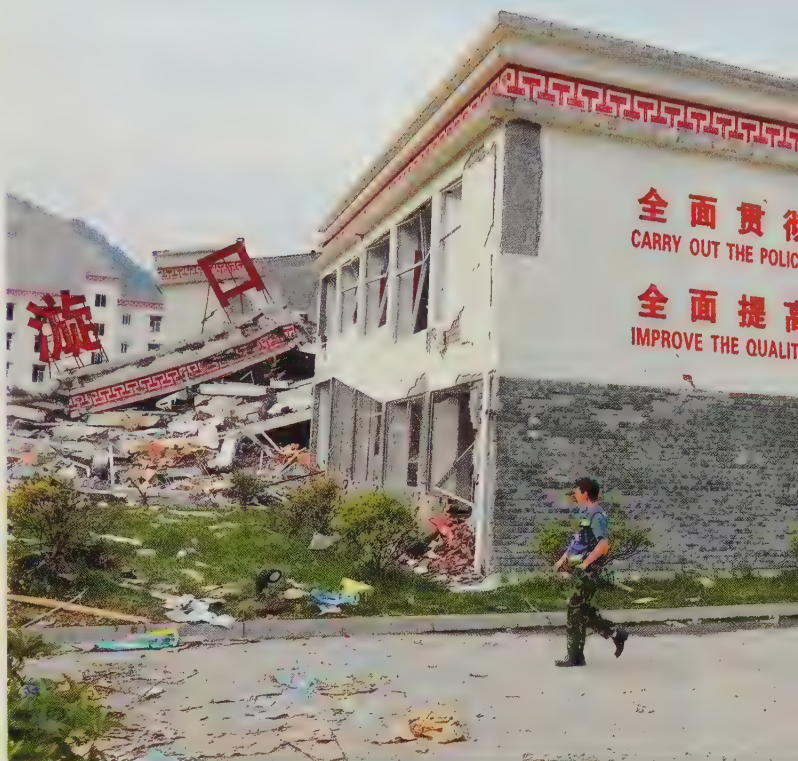
4 Une école détruite par le séisme (Yingxiu)
