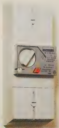
Le disjoncteur coupe automatiquement le courant quand il est trop fort.
