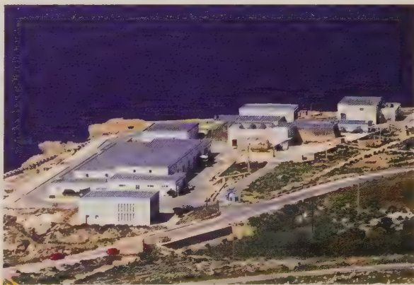
Une usine de dessalement d'eau de mer. C'est au Moyen-Orient, région sèche, que se trouvent les plus gros producteurs d'eau douce.
