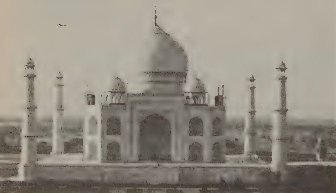
Le Tāj Mahal à Āgrā. Mausolée de marbre blanc érigé entre 1631 et 1641. [R. Michaud-Rapho]
