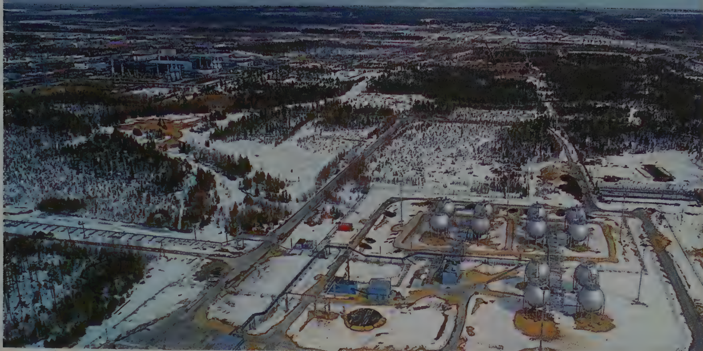
4 Une installation de stockage de gaz dans la région de Tioumen
