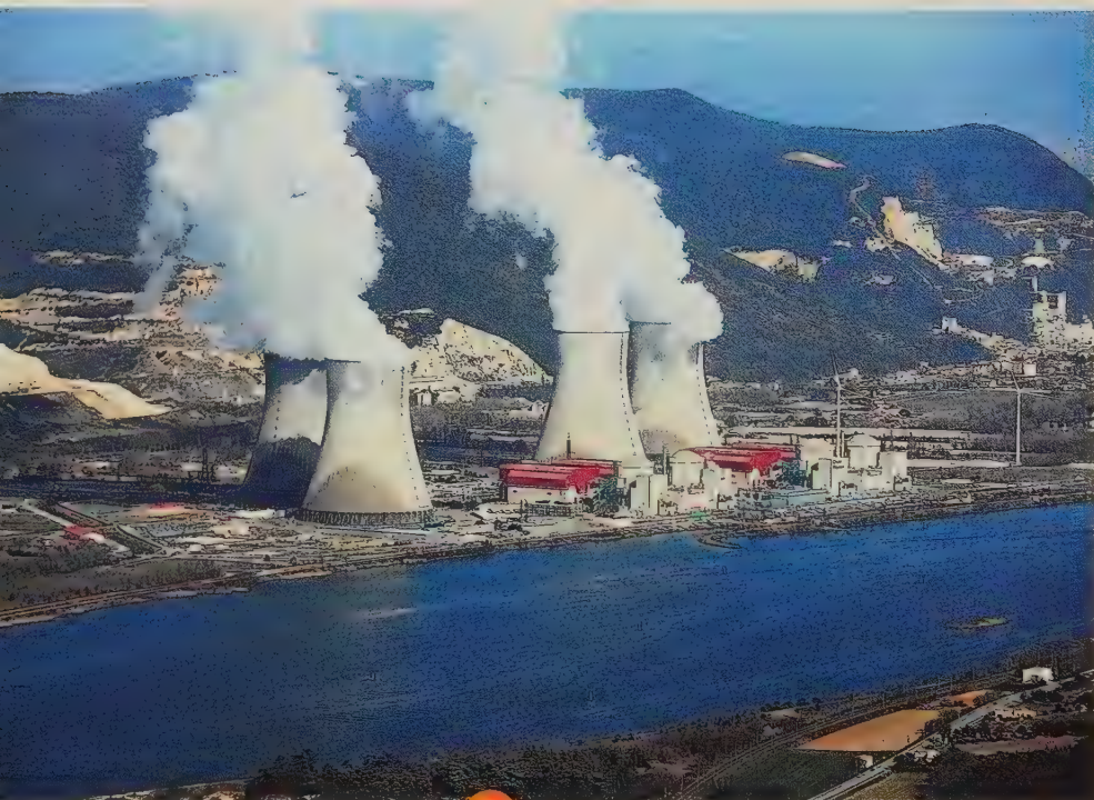
1 Centrale nucléaire de Cruas, Ardèche (France), 2008.
