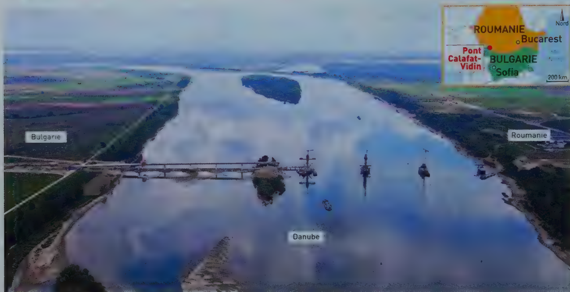
1 | Le pont Calafat-Vidin entre la Roumanie et la Bulgarie. La fin des travaux est prévue en 2012.
