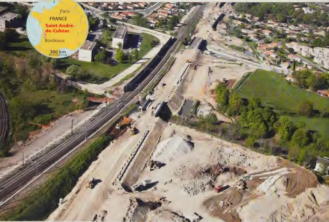
1 | Vue aérienne du viaduc de la Dordogne à Saint André de Cubzac (33)
