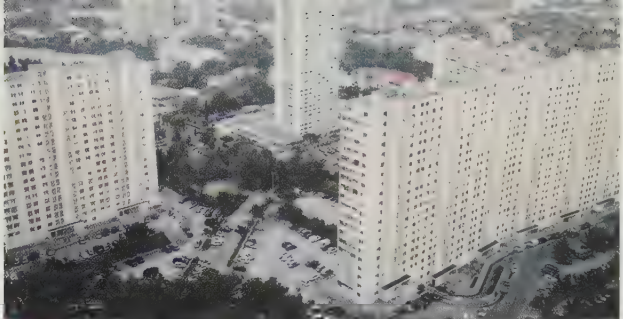
2 Trois des sept bâtiments de la cité de la Rouvière (Marseille)
