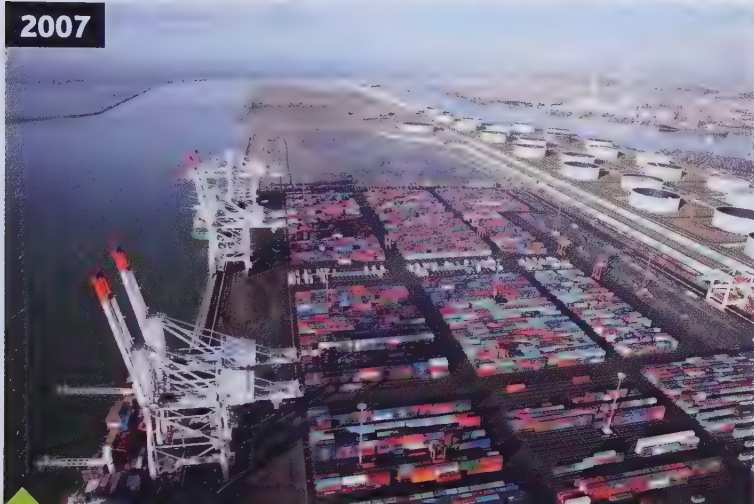
3 Le grand chantier de Port 2000.
