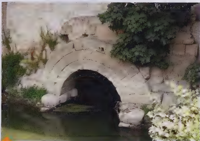
7 « Cloaca Maxima ». Égout construit par le roi étrusque Tarquin le Superbe au VI e siècle av. J.-C.
