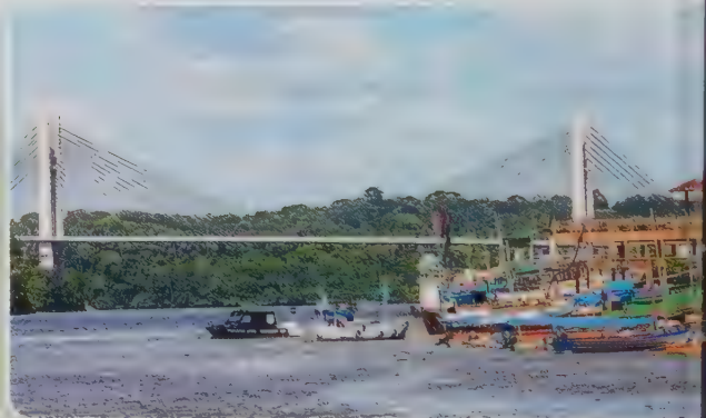
Le pont sur l'Oyapock entre la Guyane et le Brésil
