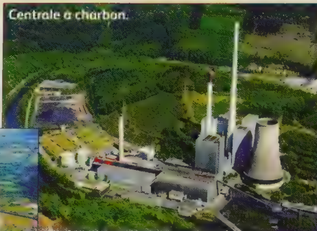
Centrale à charbon.
