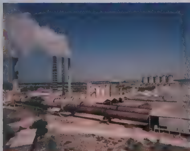
5 Une cimenterie, source importante de CO 2 à l'échelle mondiale. Chaque tonne de ciment produite requiert l'équivalent de 60 à 130 kg de fuel, soit une moyenne de 110 kWh.
