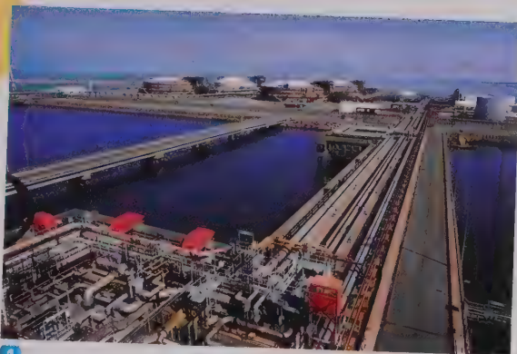
1 Terminal de gaz liquide au Qatar.
