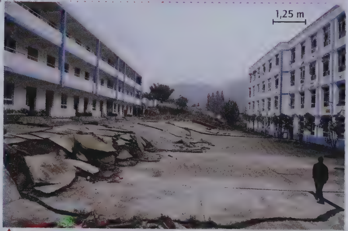
▲ Dégâts en surface dus au séisme du Sichuan (Chine) de mai 2008.
