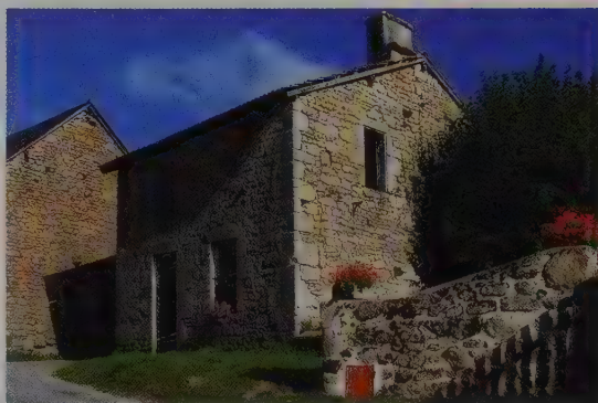
Maison en granite
