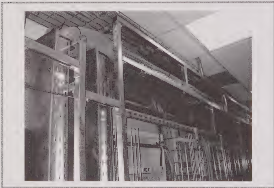
Figure 2.15 – Exemple de maillage des masses en trois dimensions.
