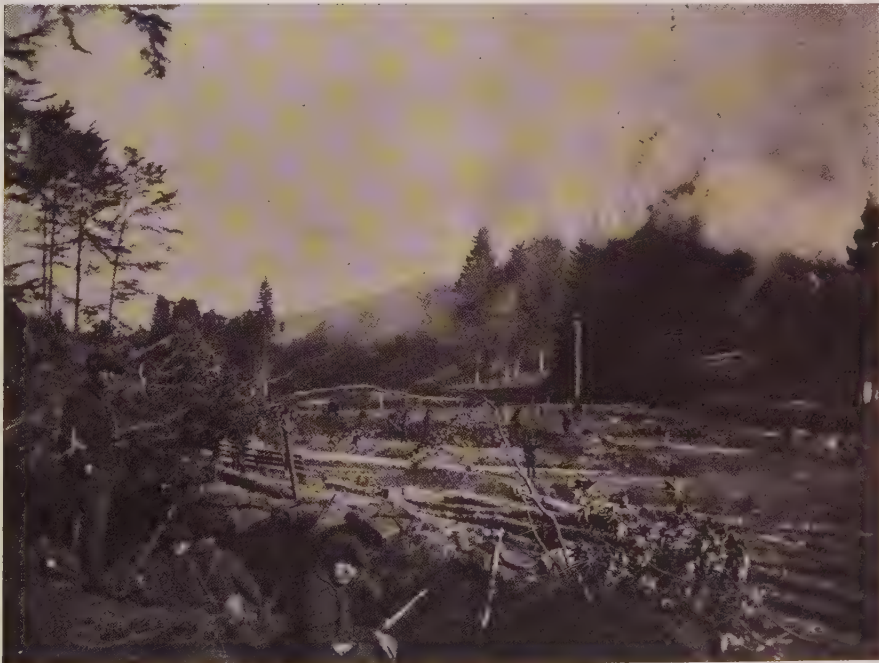
Figure 7-2 : Un exemple de tranchée improvisée dans les Vosges en 1914. Pas de créneaux, d'abris, et il faut même abattre les arbres devant les lignes pour disposer d'un peu de visibilité.
