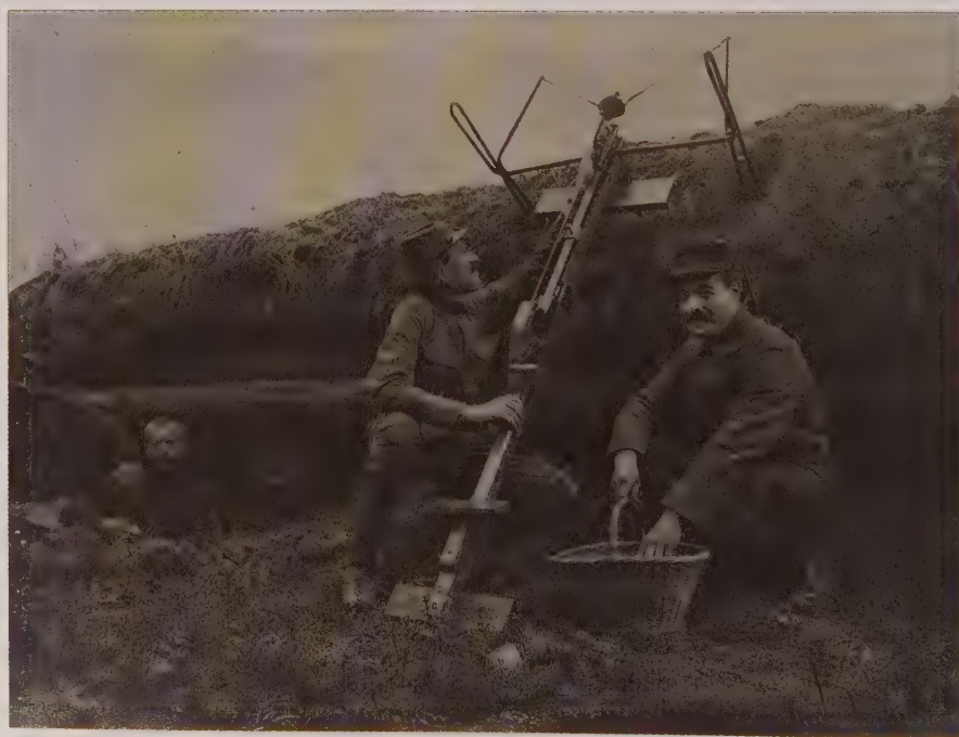
Figure 7-4 : La plus moderne des guerres voit cependant ressurgir des armes archaïques. Ainsi cette arbalète, adaptée au lancer de grenade.
