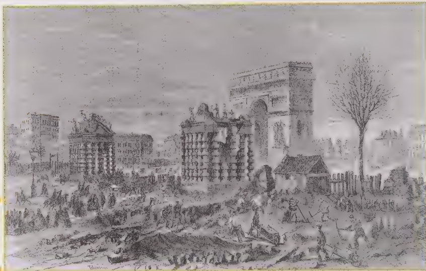
Figure 17-3 : Grands travaux à Paris.
