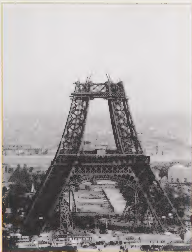
Figure 18-6 : La tour Eiffel en construction.
