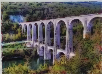
La rivière passe sous le viaduc .
