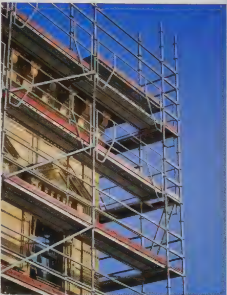
On a mis un échafaudage pour réparer le bâtiment.
