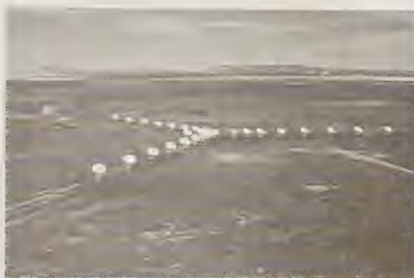
Figure 9. À gauche, le radio télescope d'Effelsberg en Allemagne, travaillant dans les ondes centimétriques. Avec un diamètre de 100 mètres, c'est un des plus grands radiotélescopes orientables au monde. À droite, le Very Large Array, premier grand réseau de radiotélescopes, composés de 27 antennes de 25 mètres de diamètre, déplaçables sur 20 kilomètres. Il est présenté ici en configuration « compacte » (cf. cahier couleur, planche 12).
