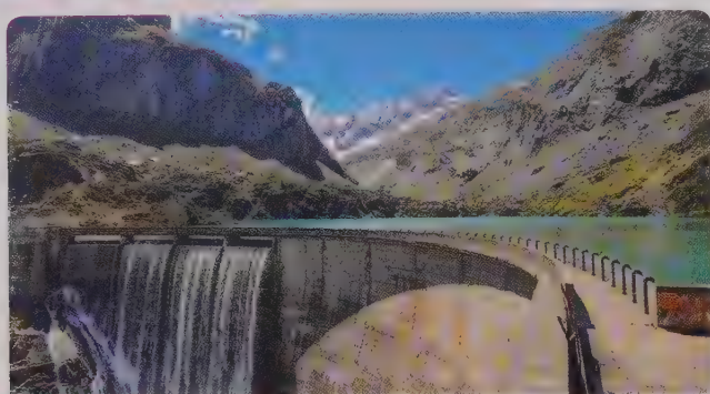
Doc. 1 Barrage hydroélectrique
