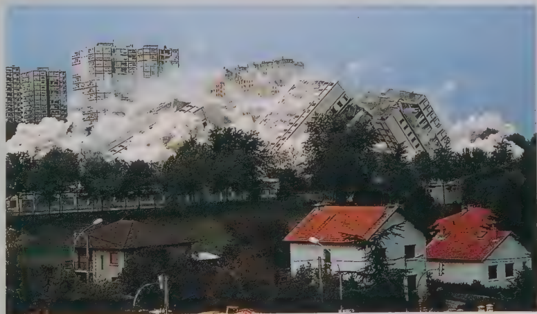
6 Destruction d'immeubles dégradés à Vénissieux près de Lyon en 1994
