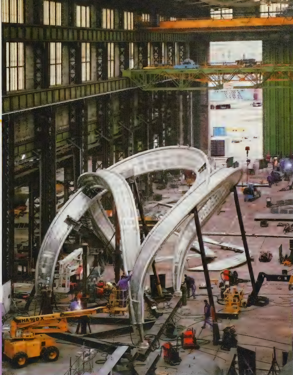
Frank Stella (né en 1936), construction du kiosque à musique dans les hangars des chantiers navals de Cherbourg, 2001. (La photo montre l'envergure de cette œuvre de plus de dix mètres de haut. Le chantier naval français a relevé le défi que représente le montage – avant son installation à Miami – de cette structure complexe en aluminium imaginée par l'artiste américain.)
