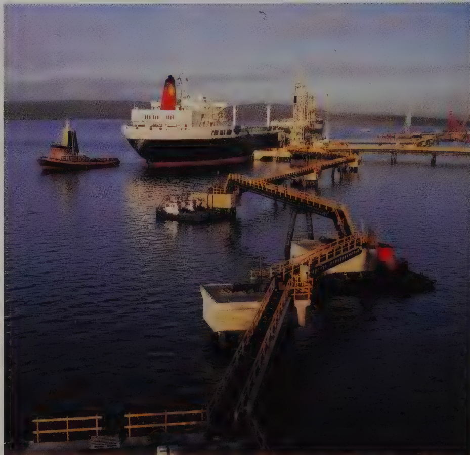
Le terminal pétrolier de Sullom Voe, dans les îles Shetland. Le pétrole y arrive par pipe-lines et pétroliers venant des champs pétrolifères de la mer du Nord. De là, des superpétroliers transportent le pétrole vers l'Europe ou les États-Unis.
