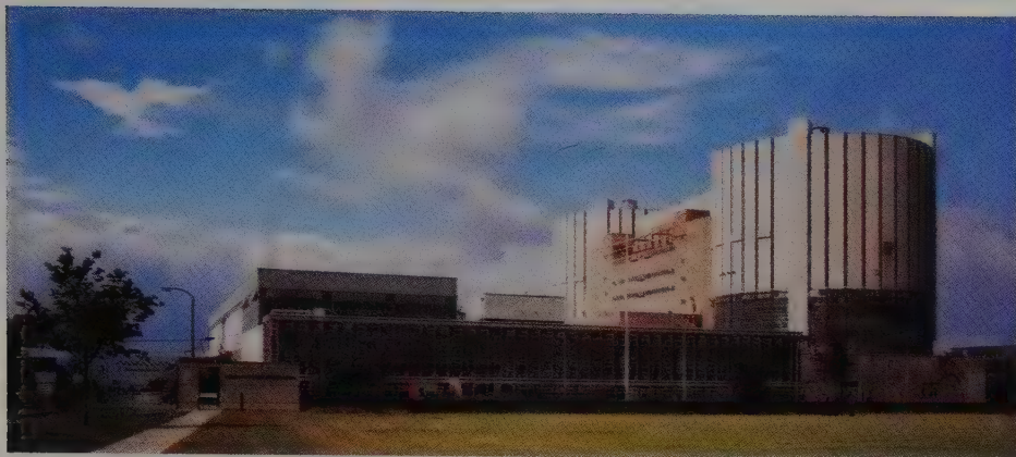
La centrale nucléaire d'Oldbury, en Grande-Bretagne, fut la première centrale nucléaire utilisant des réacteurs enfermés dans des cuves en béton.
